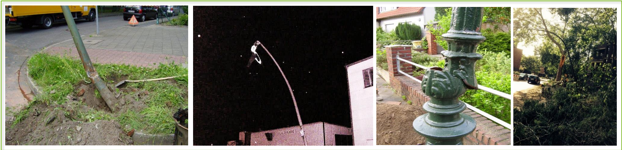
Sturmschaden, abgeknickter Mast
