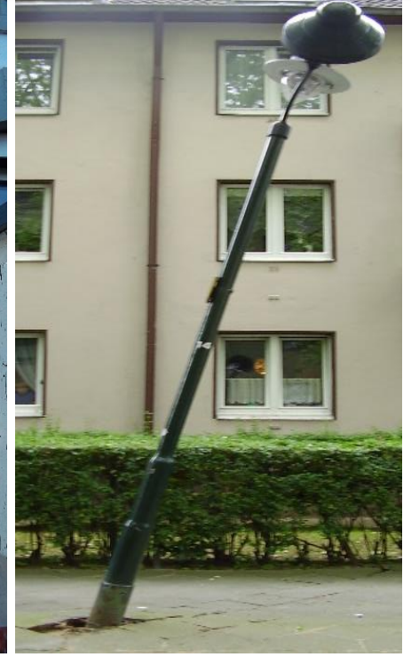
Unfallschaden, angeknickte Aufsatzleuchte
