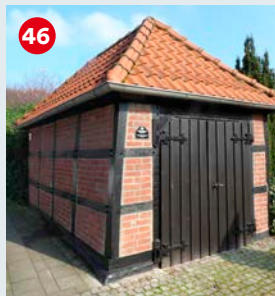
Das Spritzenhäuschen nach der Sanierung.
